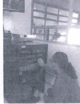
Revisión de conexiones y limpieza en rack
