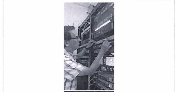
Limpieza al distribuidor de sincronía
