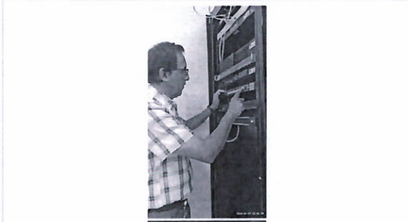
Ajuste de parámetros en el decoder y limpieza en seco
