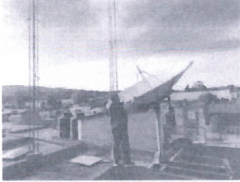
Limpieza y revisión de antenas
