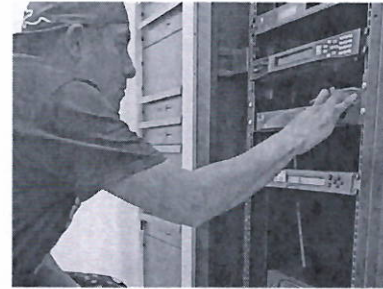
Se realiza revisión de receptor satelital (11dB)
