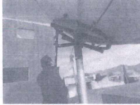
Revisión de conexiones en antena
