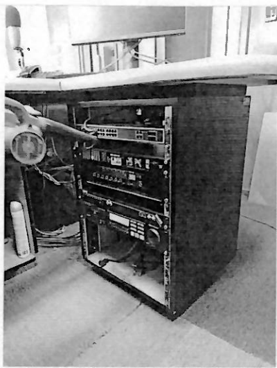
Limpieza del rack de los equipos de transmisión y de CPUs
