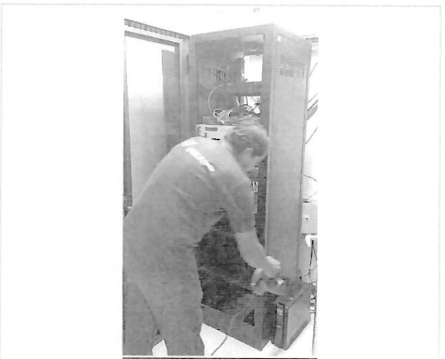
Limpieza del rack de los equipos de transmisión en el rack de transmisión y UPS
