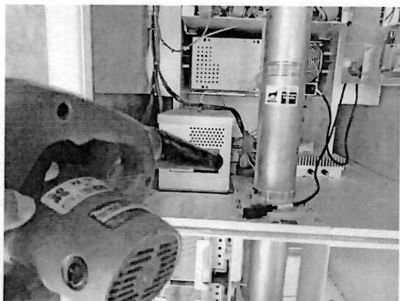
Mantenimiento limpieza al transmisor de FM los módulos amplificadores revisión de cableado voltajes y línea de transmisión
